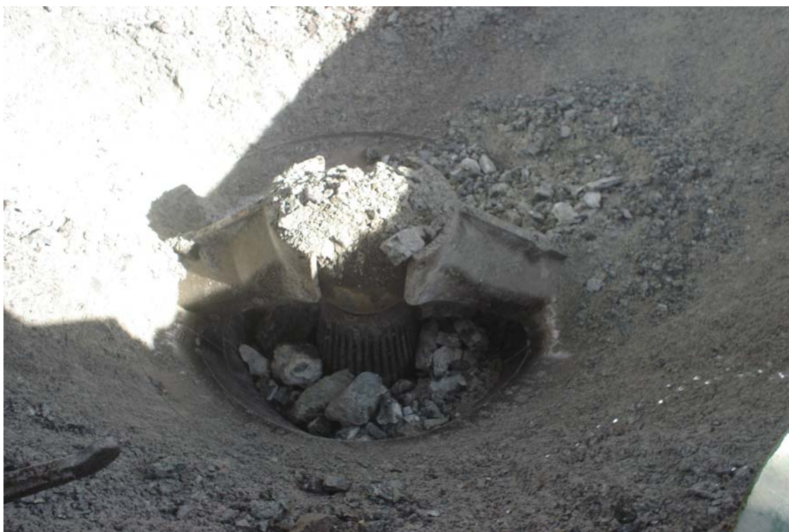
Foto nº 6 - As rochas sendo trituradas na britagem primária
